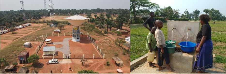
Alimentation en Eau Potable en milieu Rural dans les provinces de Kasai, Kasai central, Kasai Oriental, Lomami et Sankuru.
