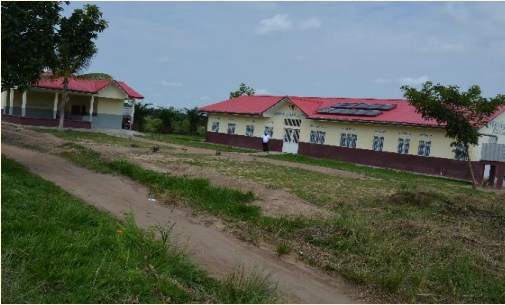
Centres de santé construits et équipés
